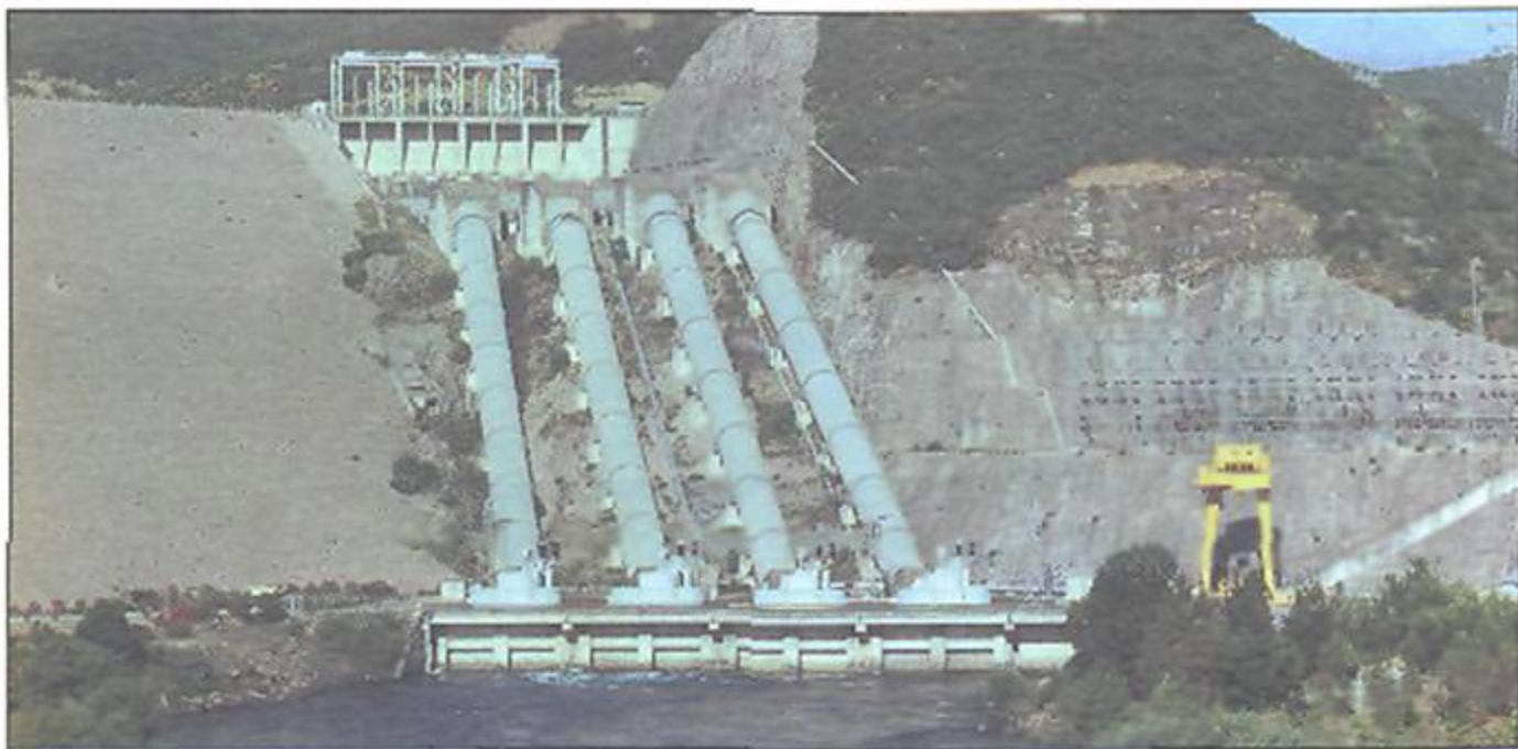
Υδροηλεκτρικό εργοστάσιο Καπιτρκάκου.
