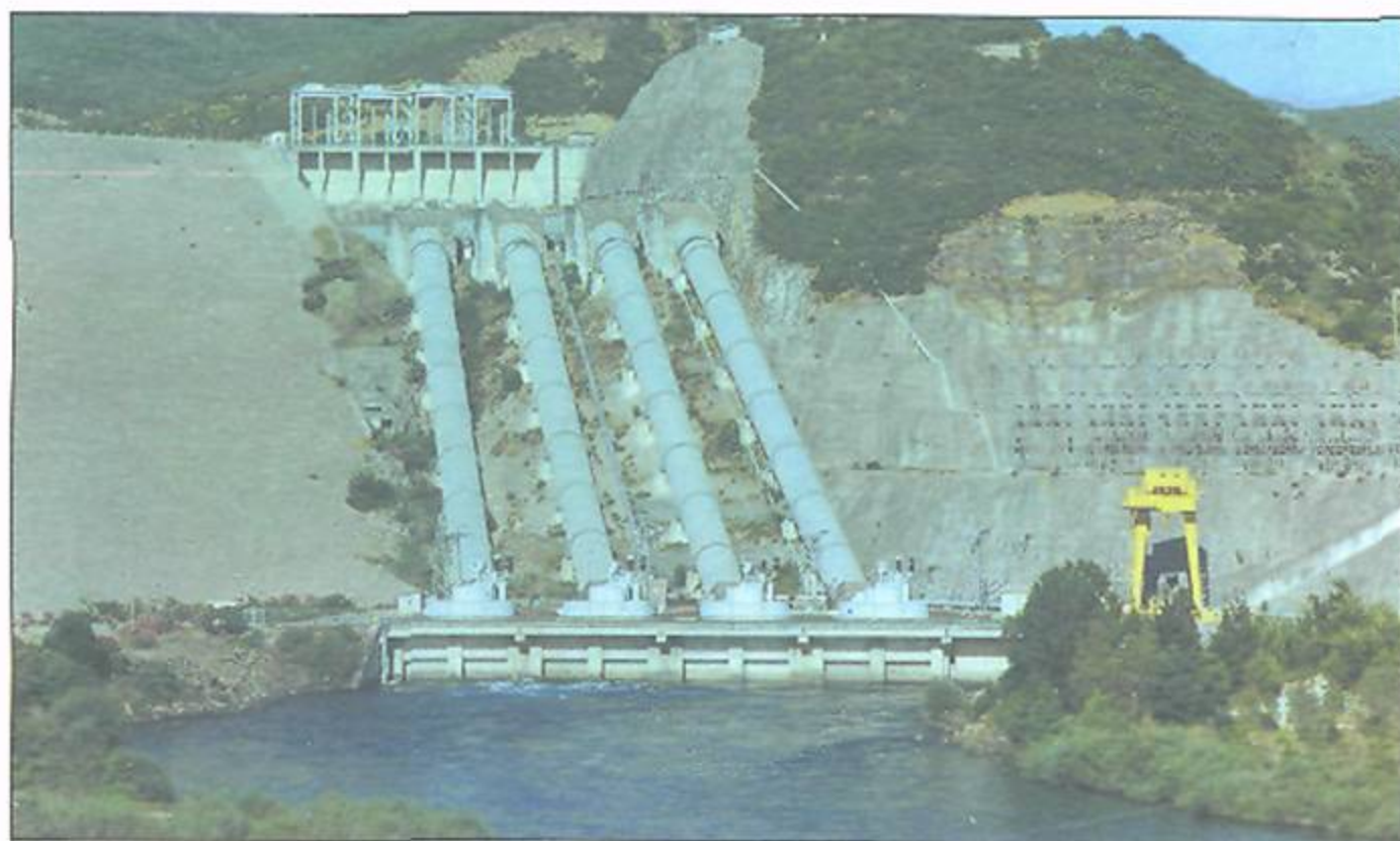
Υδροηλεκτρικό εργοστάσιο Κοιτσρακίου
